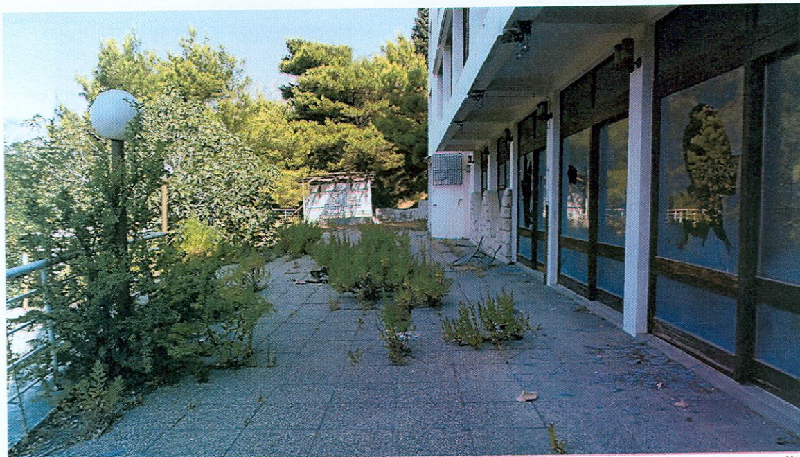
16. Plato ispred ulaza u hotel-zbog neodržavanja vegetacija prorasta između kulir opločnika . Vidljiva su razbijena stakla na fasadi
