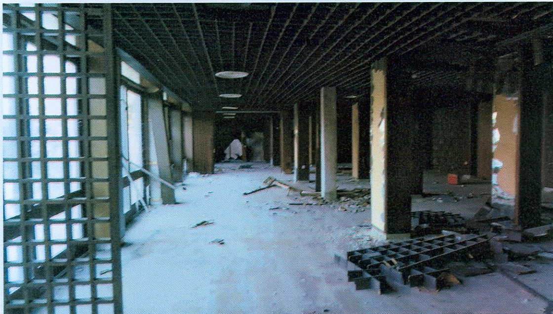
3. Prostor restorana – vidljivi tragovi devastacije-oštećeni stropovi, potrgane instalacije i polupani prozori
