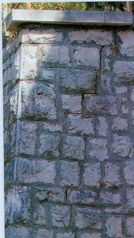
17. Oštećena ograda na potpornom zidu lijevo , pukotina na vertikalnom zidu pored pristupnih stepenica – potrebno je izvesti odgovarajuće sanacione radove na objektu
