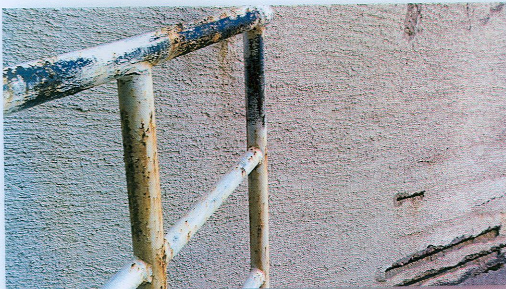
17. Oštećena ograda na potpornom zidu lijevo , pukotina na vertikalnom zidu pored pristupnih stepenica – potrebno je izvesti odgovarajuće sanacione radove na objektu
