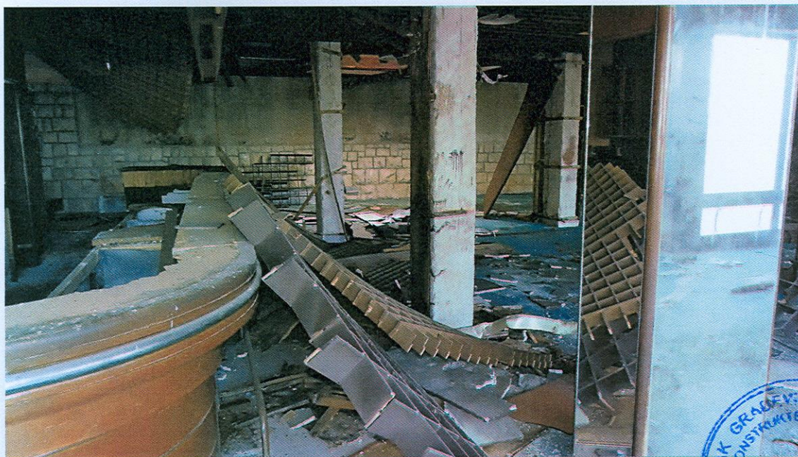
3. Prostor restorana – vidljivi tragovi devastacije-oštećeni stropovi, potrgane instalacije i polupani prozori
