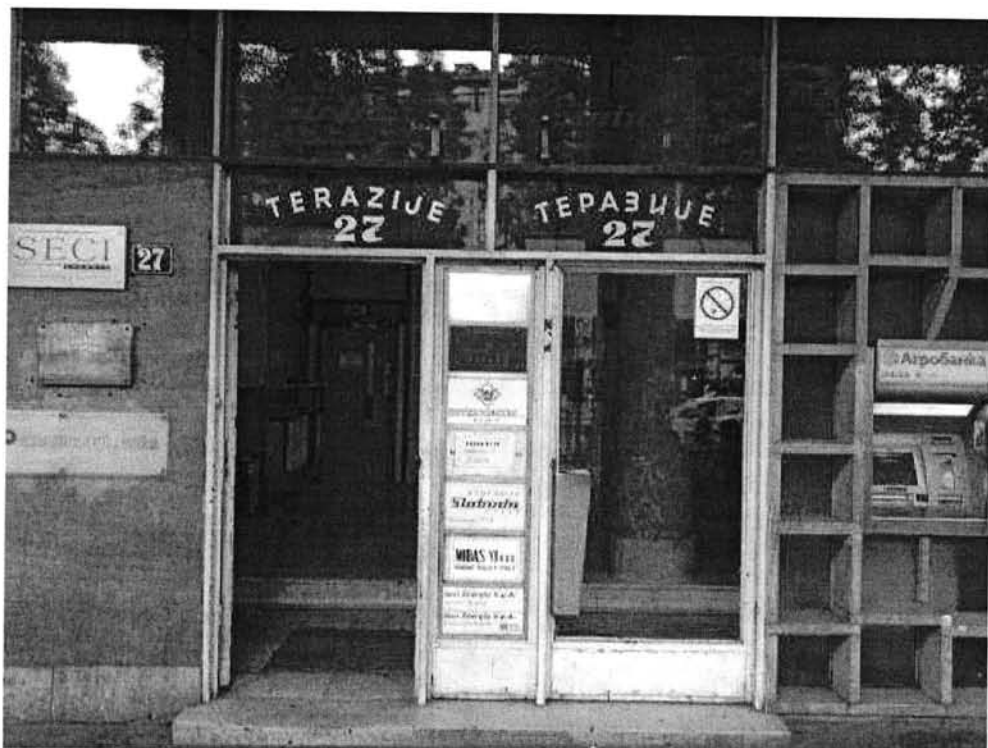
Izvor: CB Richard Ellis, ulaz u zgradu
