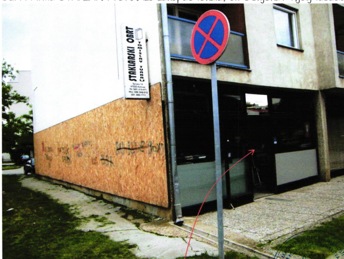
SL.2. LOKALA, GLAVNA FASADA, ul. Senjska 14, Karlovac, istočna fasada
