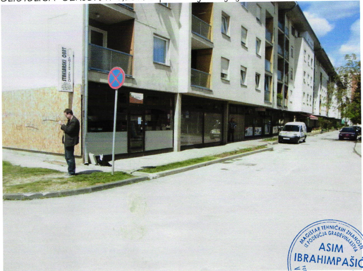
SL.6. PROSTORIJE lokala, glavna fasada SENJSKA I 4, Karlovac
