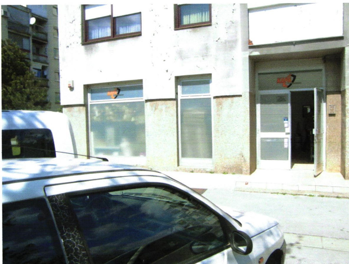
Poslovni prostor-lokal, ul. Hebrangova, 16C u Karlovcu, gl. fasada
